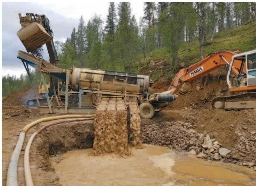
Rumpuseula pyörii Jaskarin Veikon työmaalla Selperillä. Esther kippaa kaivinkoneen kauballa soraa seulan kitaan. Seulassa on neljä ränniä, oikeanpuoleiseen, jossa on 45 millimetrinen verkko, jää karkein kiviaines ja hienojakoisempi aines kolmeen viereiseen ränniin, joissa on 15 millimetrin verkko. Kuva: Liisa Hertell
